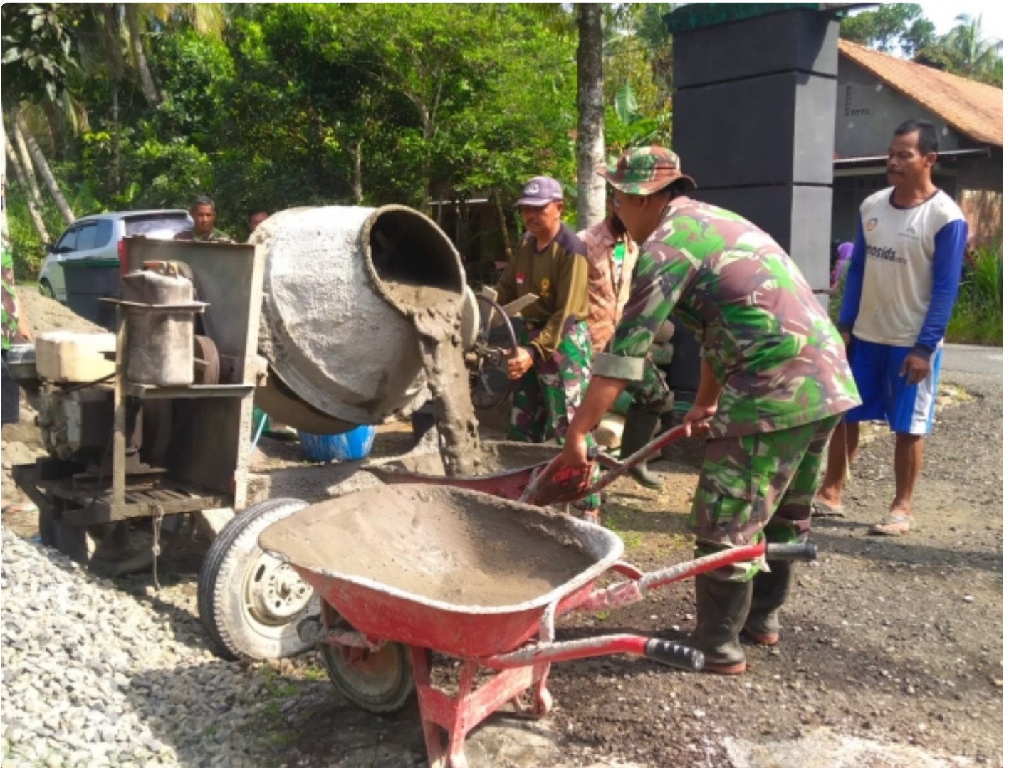
Anggota Posramil Bonorowo Bantu Warga Pengecoran Jalan
